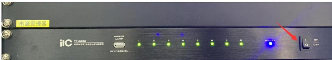
三、关闭左侧空开，左侧空开关闭顺序 1-2-3-4-5
